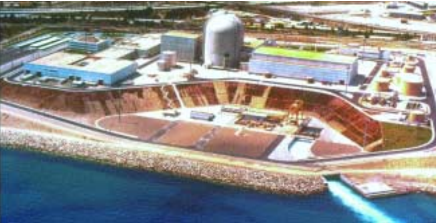
Central nuclear de Vandellós II
