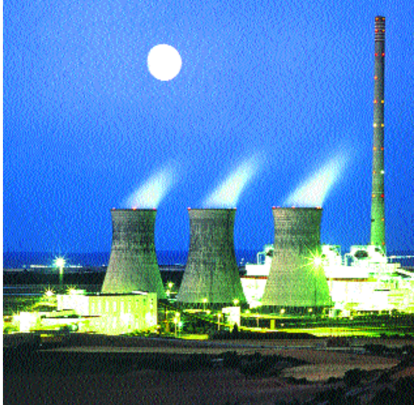
Vista nocturna de la central térmica de Teruel
