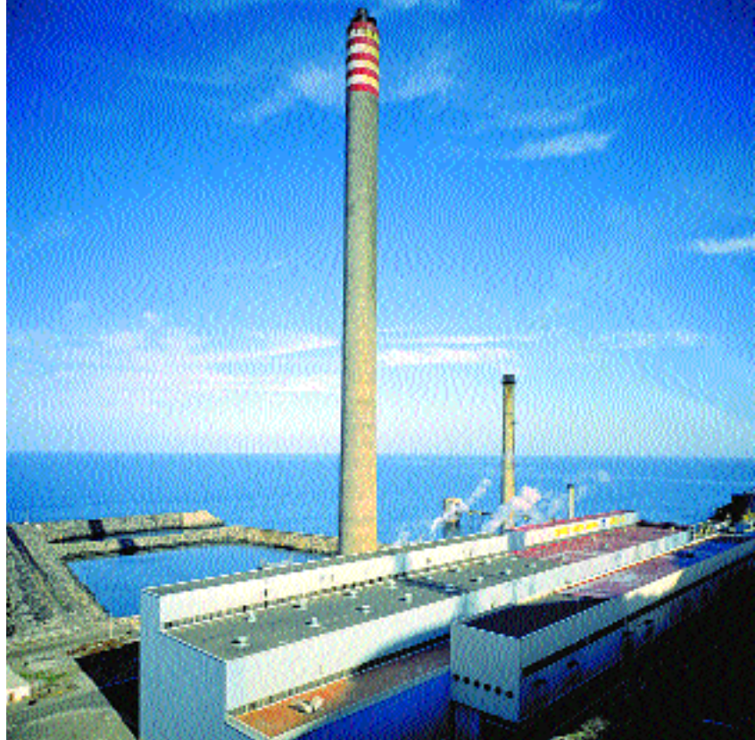
Cielo y mar enmarcan la central térmica de Jinamar
