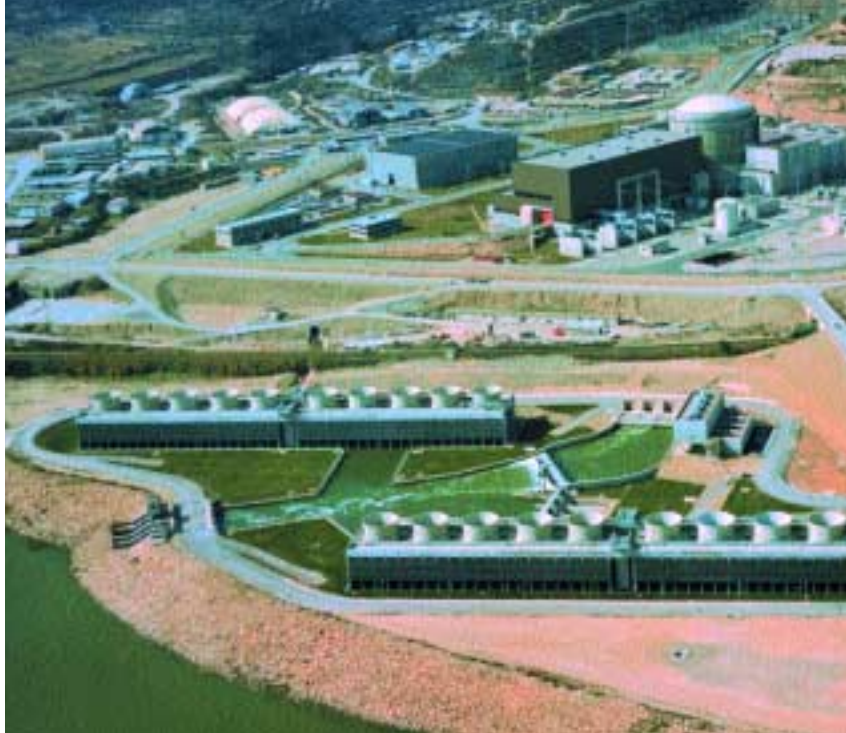
Sistema de refrigeración en batería de la central nuclear de Ascó
