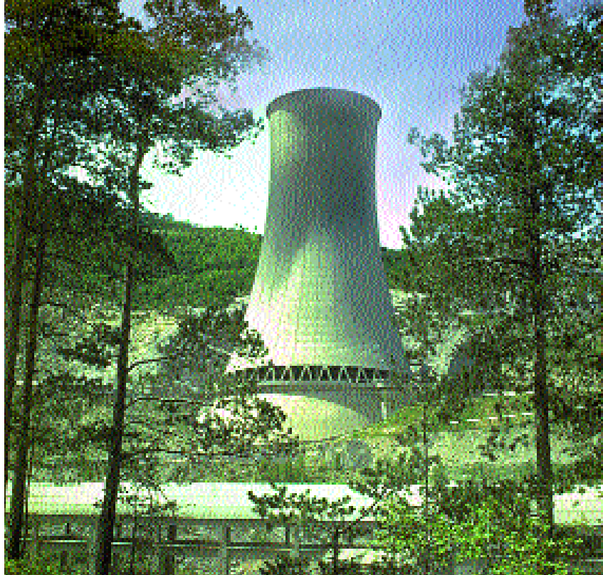
Torre de refrigeración de la central térmica de Cerch
