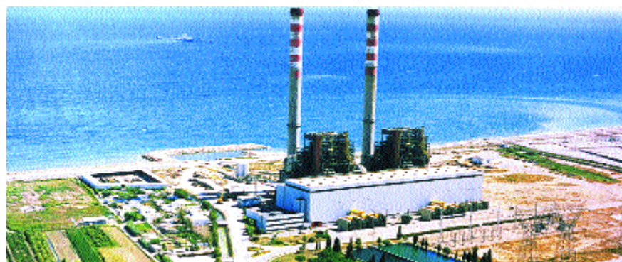
Central térmica de Castellón, una de las instalaciones pioneras en la valoración de los efectos medioambientales
