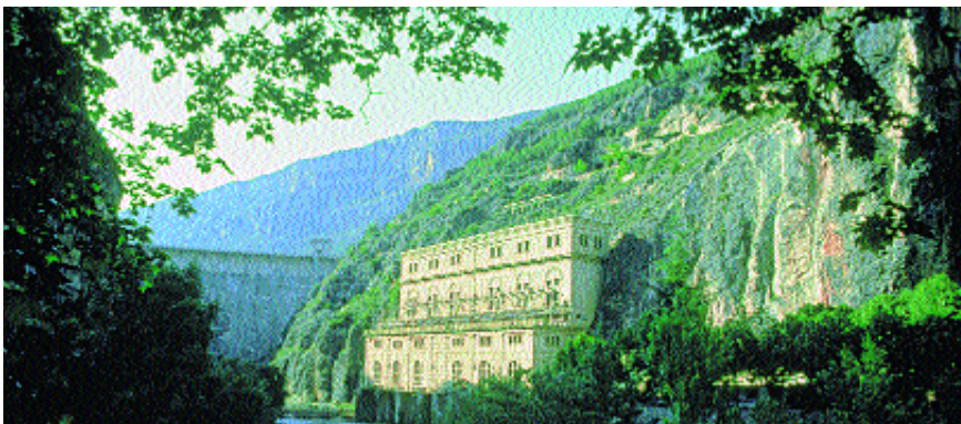
En muchísimas ocasiones, como en la central hidroeléctrica de Tabescán, su arquitectura armoniza y enriquece el paisaje
