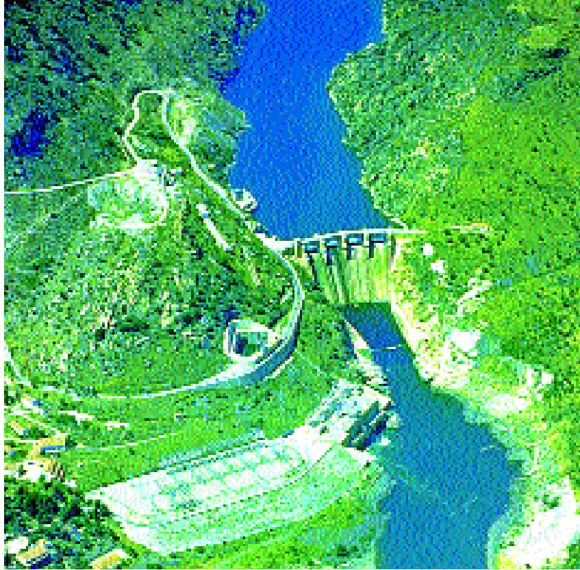
Entorno de la central hidroeléctrica de Saucelle
