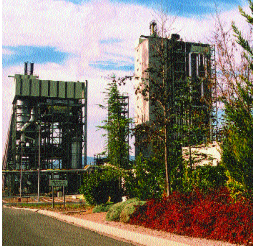
La tecnología utilizada en Elcogás, en Puertollano, es muy interesante desde el punto de vista medioambiental
