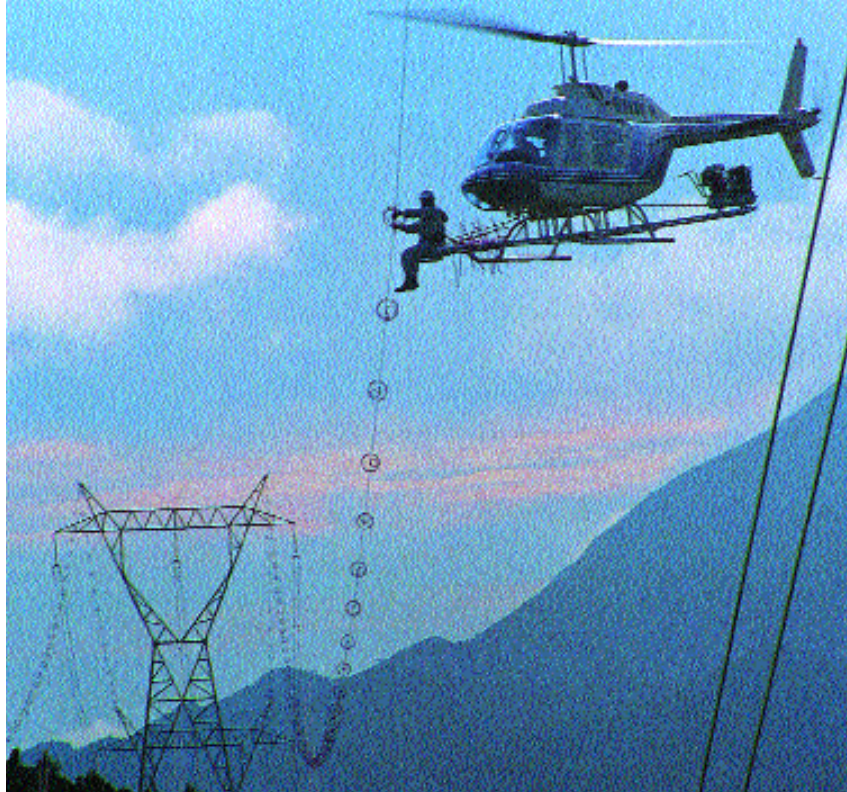
Para el mantenimiento de las grandes redes de transporte se utilizan helicópteros que mejoran la eficiencia y el impacto ambiental de estas instalaciones
