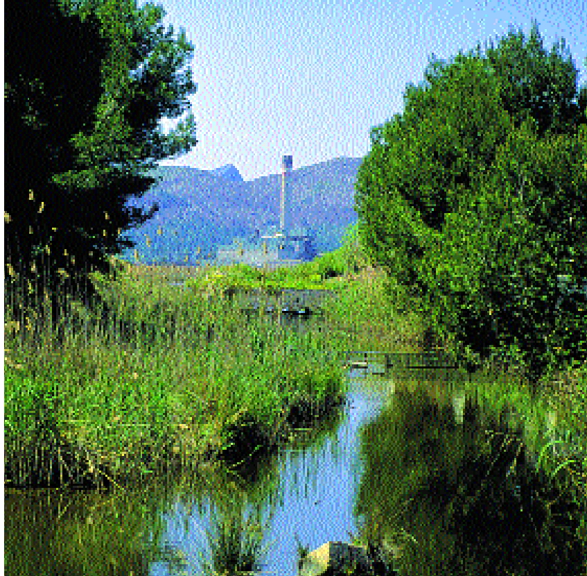
Las centrales eléctricas cuentan con sistemas para proteger el medio ambiente de los efluentes que producen. Central térmica de Alcodia
