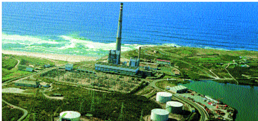
La central térmica de Sabón también utiliza agua marina para su refrigeración
