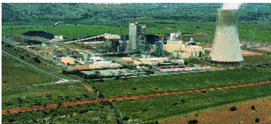
En la central térmica de Puertollano se investiga sobre "tecnologías limpias" del carbón
