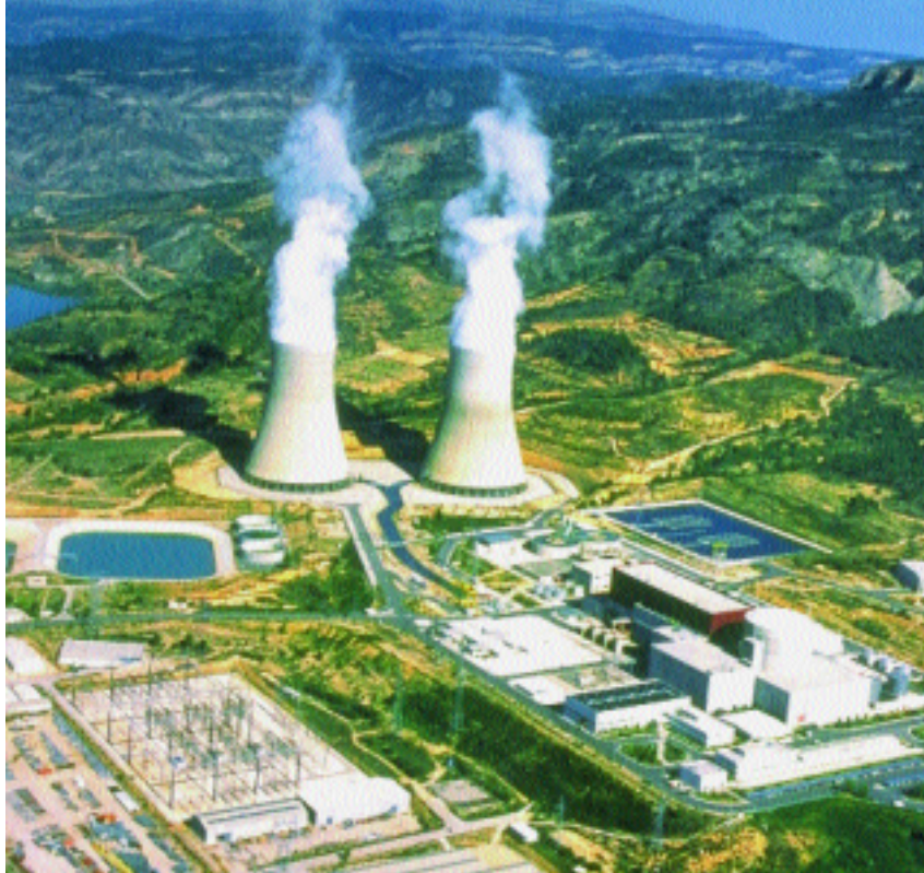
Vista general de la central nuclear de Cofrentes
