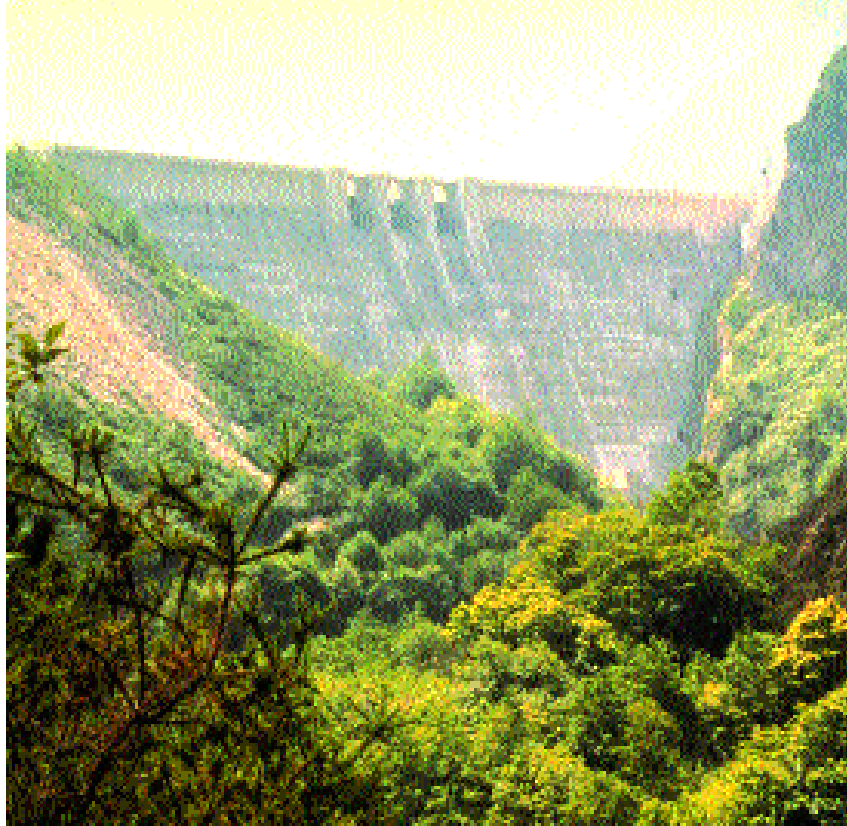
Presa construida con hormigón en el que se han utilizado cenizas volantes para su fabricación
