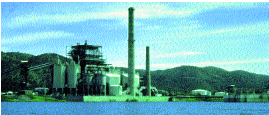
Central térmica de Puente Nuevo
