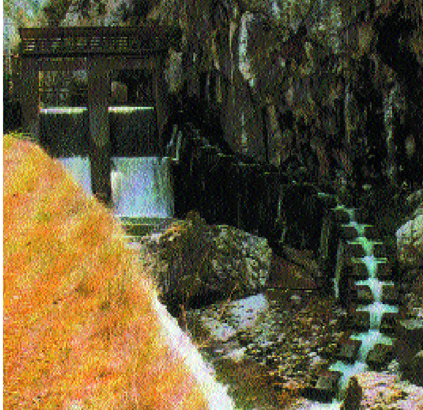
Ejemplo de una escala instalada en el río Cares
