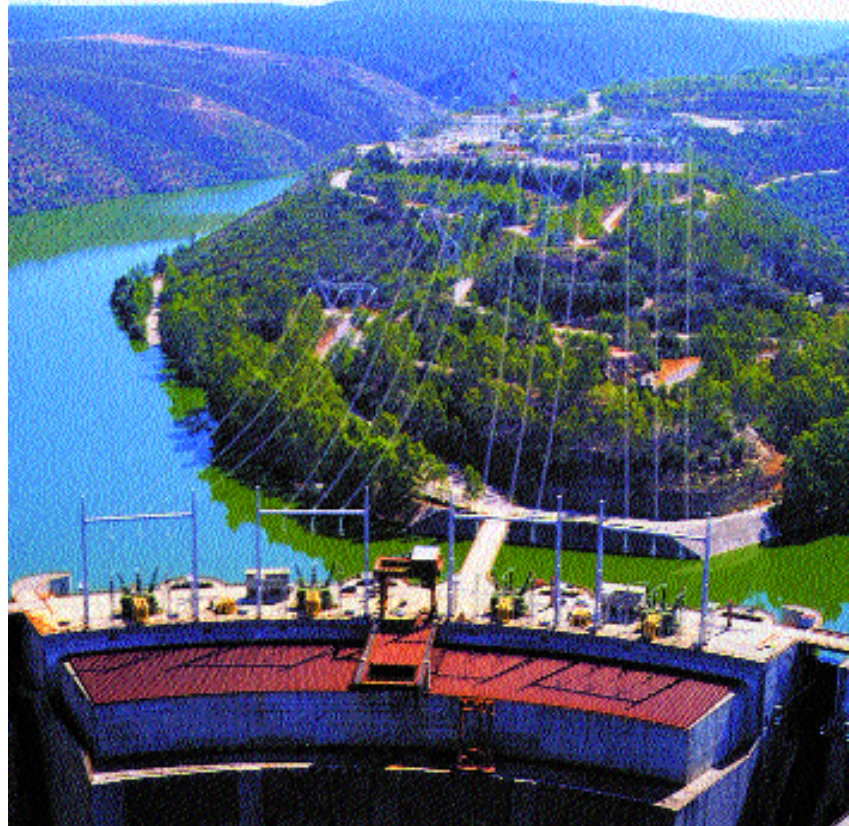
Las redes de transporte eléctrico deben salvar en ocasiones grandes obstáculos orográficos
