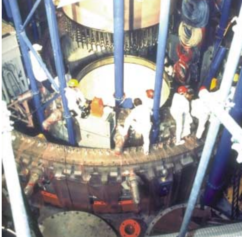
Trabajos de investigación en el reactor rápido Super Phenix
