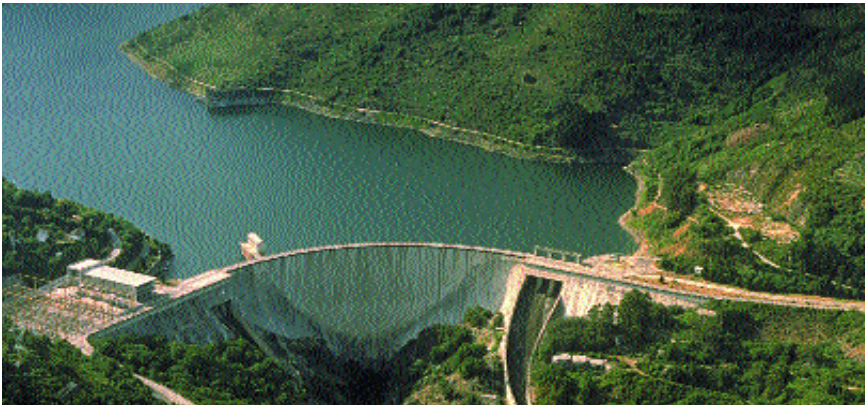
Central hidroeléctrica de Belesar
