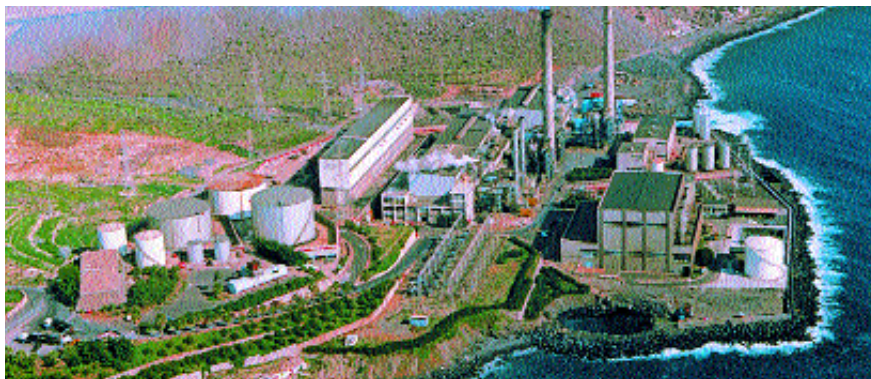
La central térmica de Candelaria utiliza el agua del mar para su refrigeración
