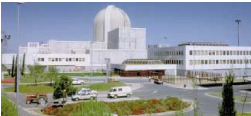
Central nuclear de Vandellós II
