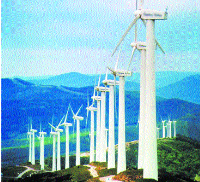
Generadores de un moderno parque eólico
