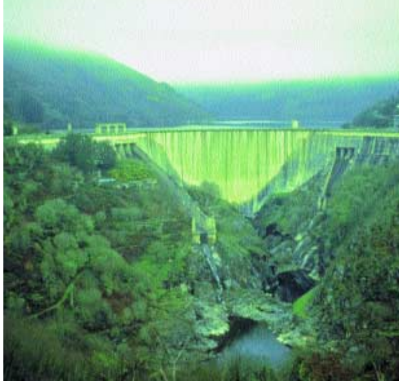
Central hidroeléctrica de Belesar
