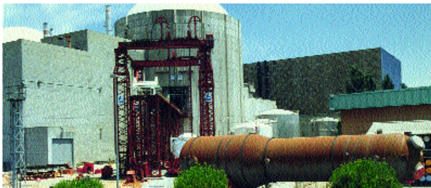
Cambio de un generador de vapor. Central nuclear de Almaraz
