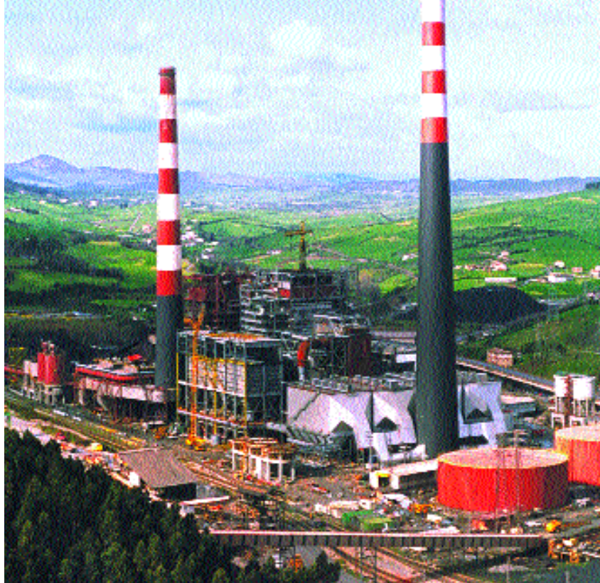
Las centrales eléctricas disponen de sistemas para reducir los niveles de contaminación acústica. Central térmica de Aboño
