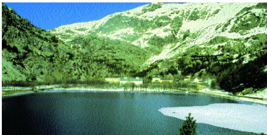
Los embalses regulan el agua de los ríos procedentes de las lluvias y de los deshielos. Central hidroeléctrica de Baños
