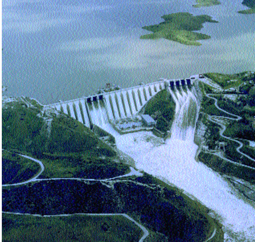
Los embalses ayudan a prevenir los efectos de las avenidas. Embalse de la Central hidroeléctrica José María Oriol
