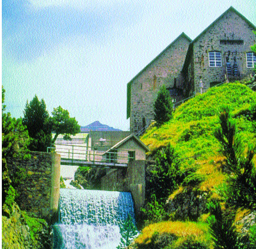
Aguas cristalinas producen energía en la central hidroeléctrica de Urdiceto
