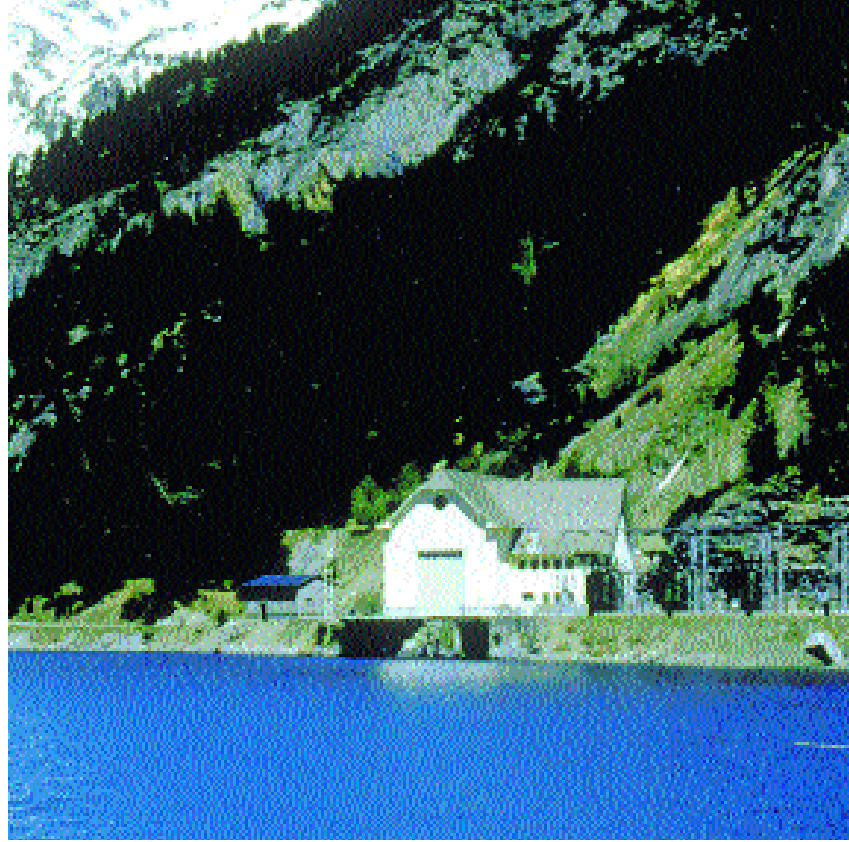
Embalse y central hidroeléctrica de La Sarra
