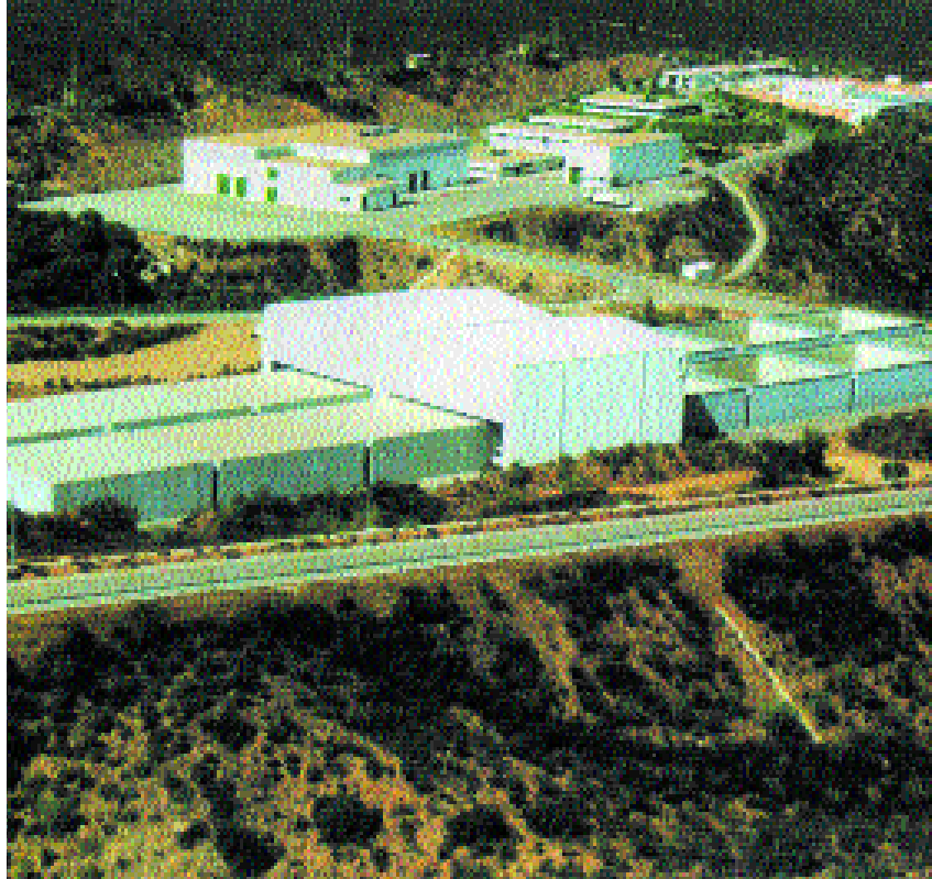
Instalación de almacenamiento de residuos radiactivos de baja y media intensidad en El Cabril
