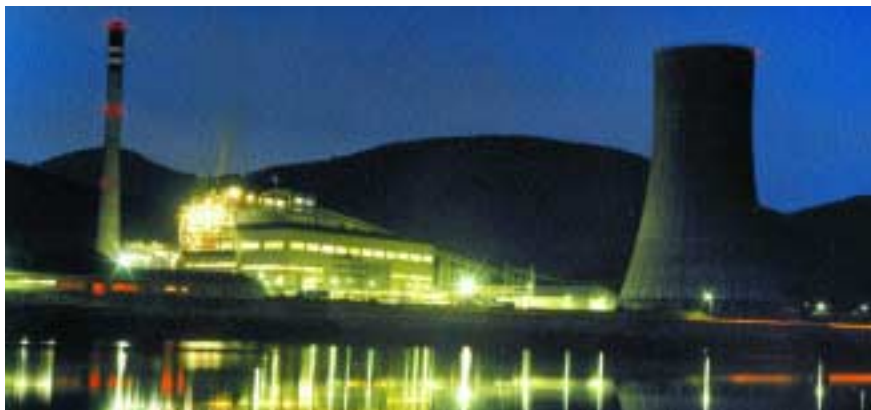
La iluminación nocturna refleja en el agua la imagen de la central térmica de Anllares
