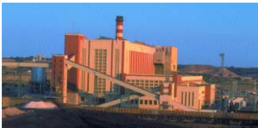
Planta de demostración de Escatrón, primera en España de lecho fluido a presión
