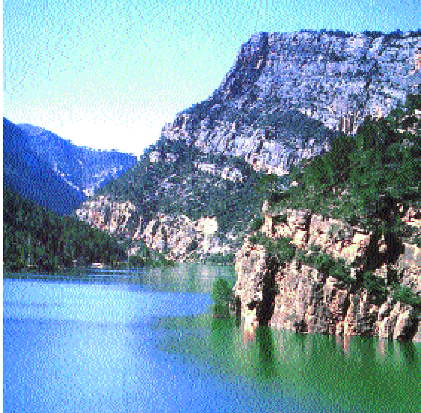
Embalse de la central hidroeléctrica Javier Relatre
