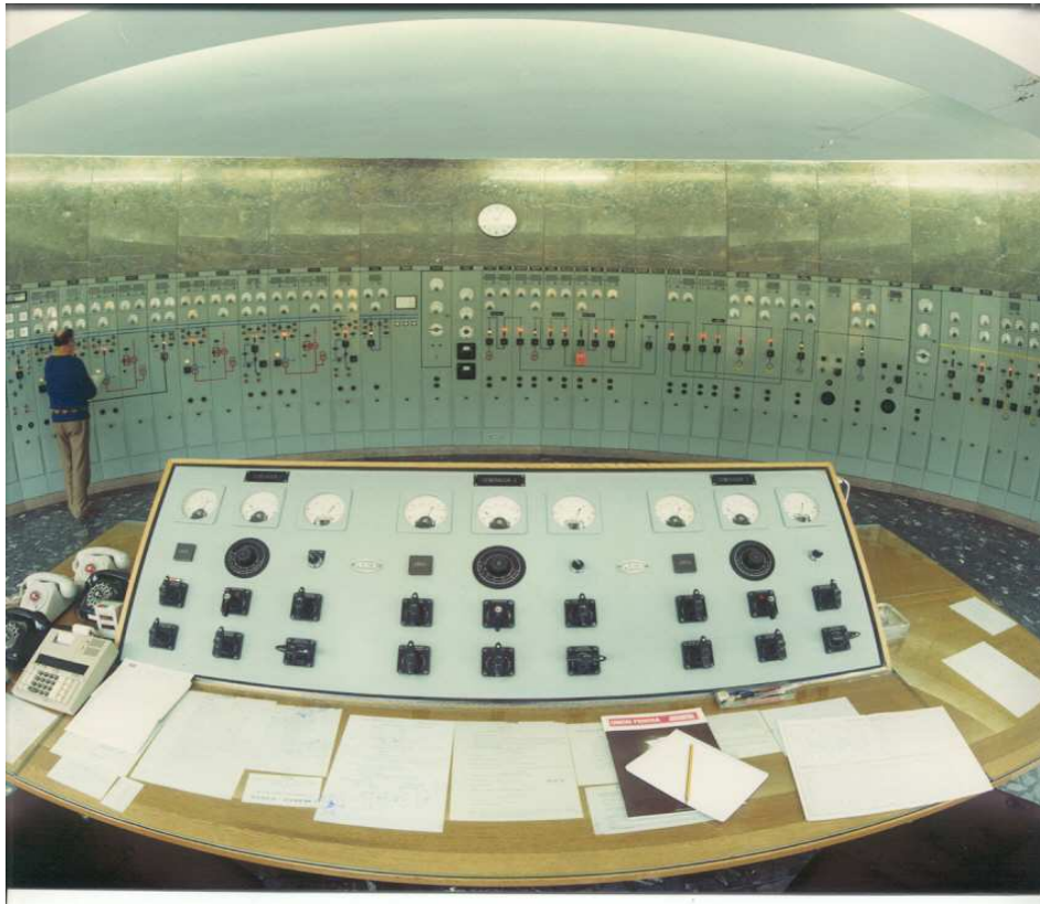
Figura 3.5. Antiguo despacho de operaciones de una central hidroeléctrica
