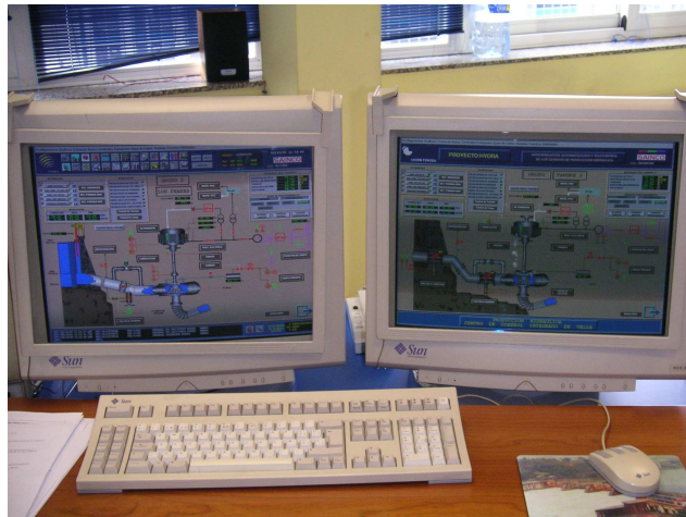
Figura 3.6. Despacho moderno de control de un buen número de centrales hidroeléctricas
