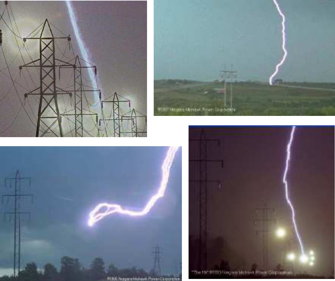
Figura 7.40. Fotografías de caída de rayos en líneas de red
